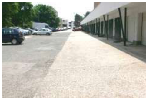
prístupová cesta ku garážam
