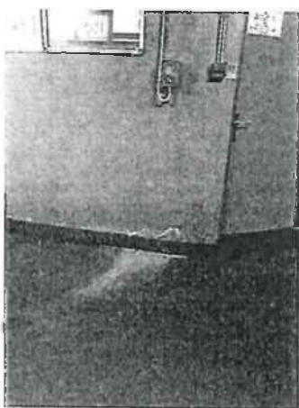
ZDROJ VLAŽNOSTI O TROŠCI IZGUBE PLEHNK VODI SPOD TORZORU NA PILOTOVEJ STENI
