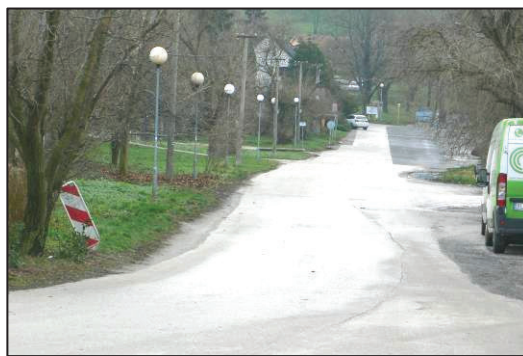
Muránska ulica-dotknuté miesto parc.č.958/27
