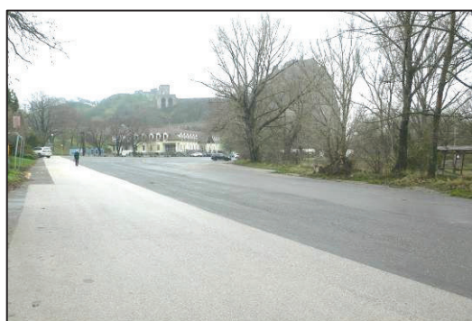
Muránska ulica-začiatok parc.č.958/10
