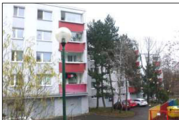
opačná strana bytového domu-vchod č.1,3,5
