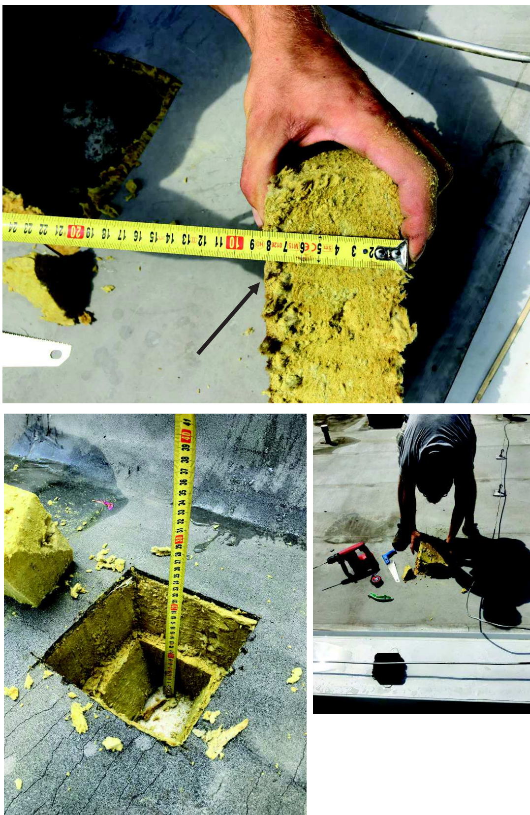
Obr.2 Overovanie hrúbky jestvujúcej tepelnej izolácie
