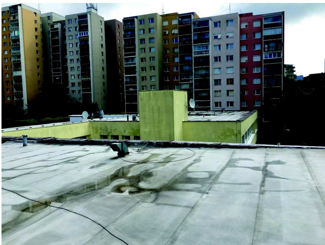
Obr.1 Pohľad na strechu Trakt A,B,C
