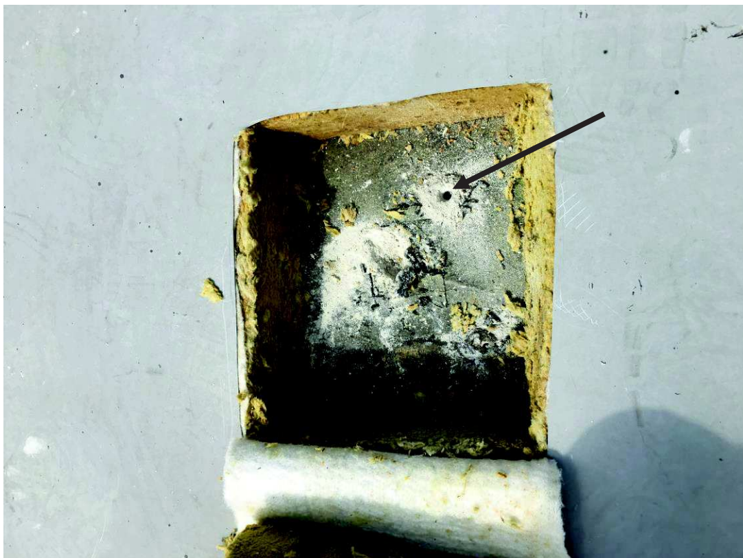
Obr.1 Pohľad na sondu, overenie skladby nosnej konštrukcie vývrtom
