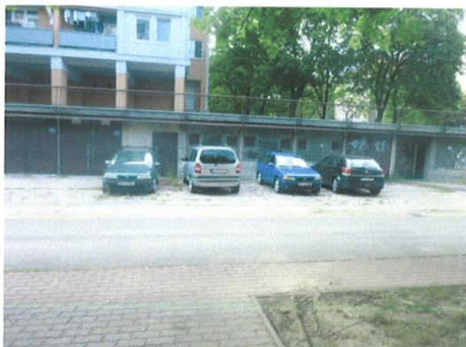
Stavba na parc. č. 11921/68
