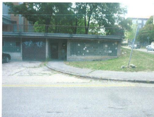
Stavba na parc. č. 11921/70
