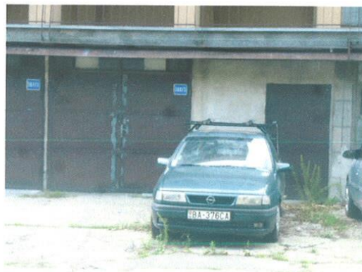
Garáž na parc. č. 11921/67
