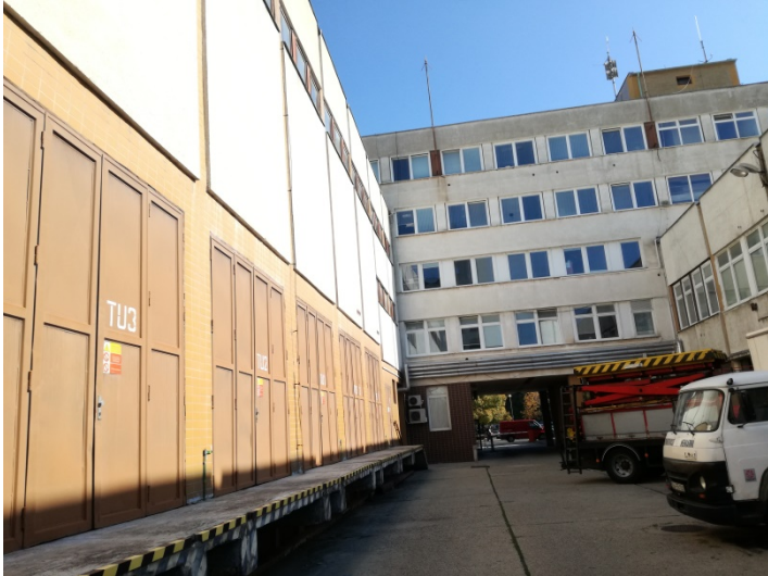
Obr. č. 4: Vnútorný dvor – strana juh
