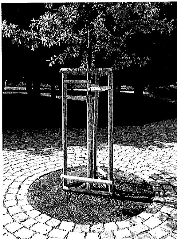
Obr.2: Požadovaný spôsob ukotvenia stromov (informatívne zobrazenie)
