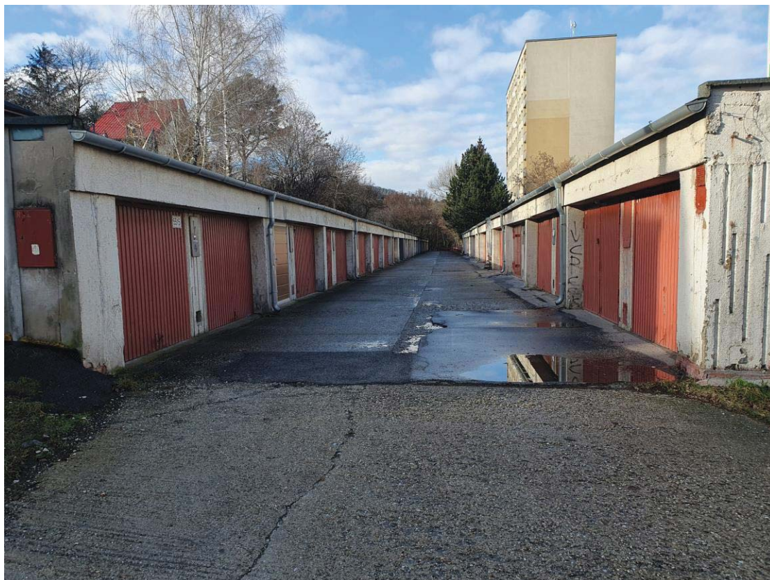
Pohľad na predmetný pozemok a okolie
