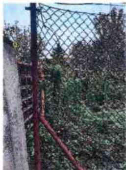
Oplotenie medzi pozemkami parc. č. 4757/27 a 4755/1, ktorá je v terénnom zlome, pohľad od západu
