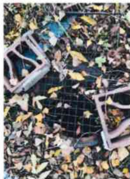
Kanalizačná šachta na pozemku parc. č. 4757/27
