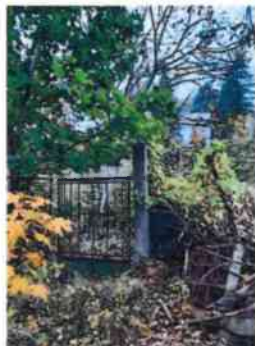
Časť oplotenia s vrátkami medzi parc. č. 4757/27 a 4755/1, pohľad od SV
