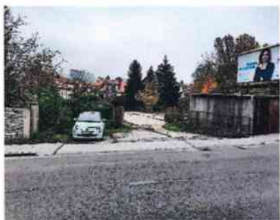
Časť JZ hranice pozemku parc. č. 4757/27 pri chodníku s vjazdom a s časťou panelovej garáže na pozemku
